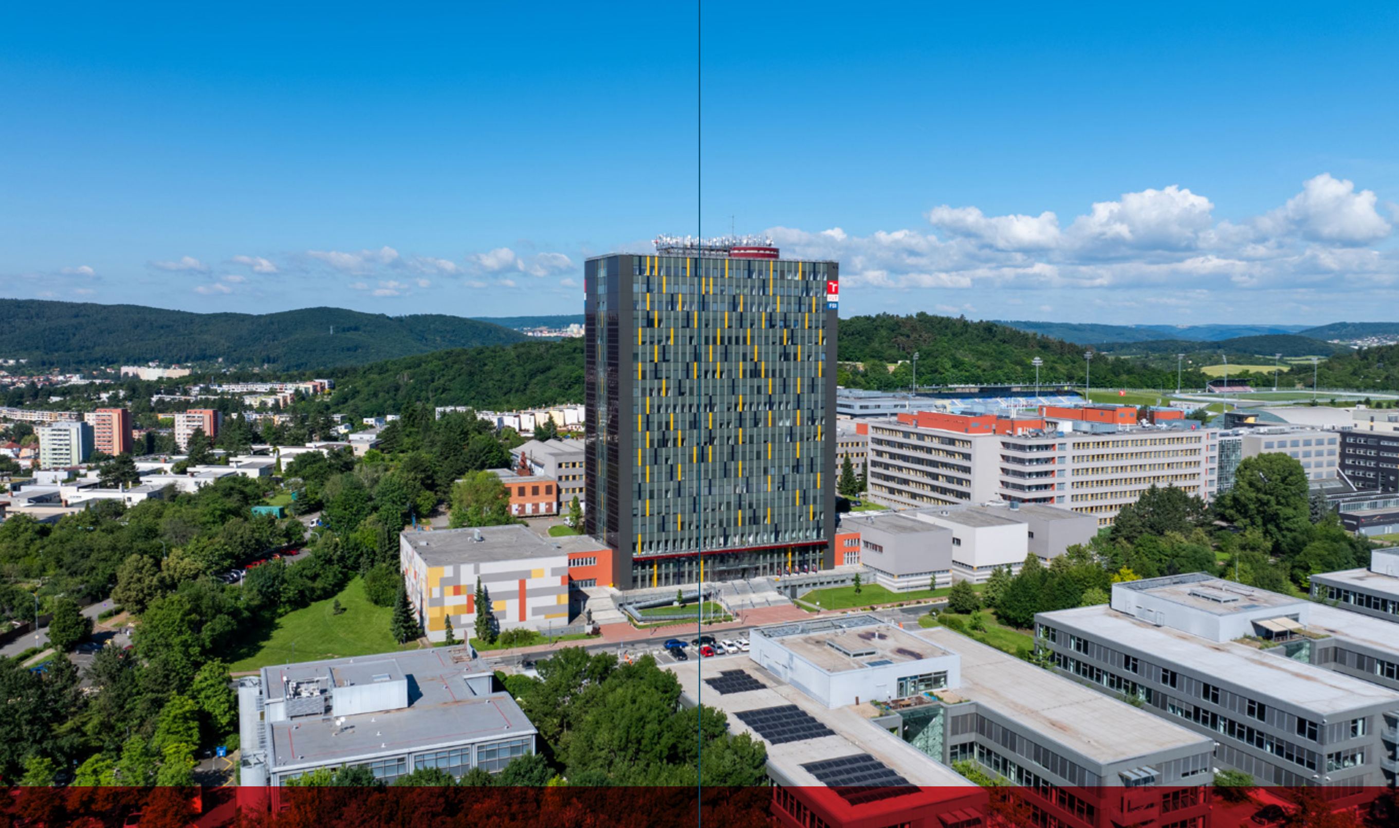
Výšková budova A1
